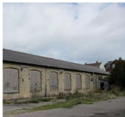
Sydligste bygning - sydfacade
