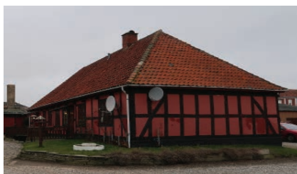
Billede 1: Knudshovedvej 25. Det bevaringsværdige hus, som der med denne lokalplan bliver mulighed for at nedrive som en del af boligprojektet.
