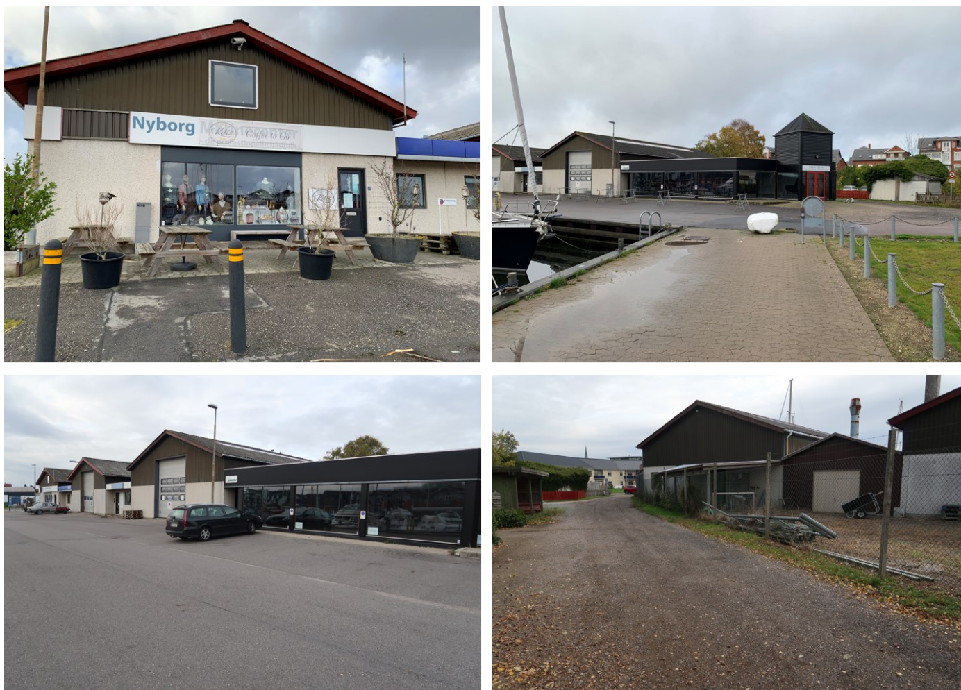
Figur 3: Bebyggelsen på ejendommene Lystbådevej 2-12, 2022. Øverst t.v. butiksfacade på bygningen længst mod syd; øverst t.h. den nordlige ende af bebyggelsen set fra havnepromenaden øst for området; nederst t.v. bebyggelsen som den fremstår langs havnepromenaden; nederst t.h. bebyggelsen set fra "bagsiden" mod haverne til boligerne langs Dyrehavevej.
