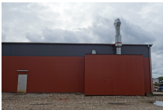
Figur 5 - De gennemgående farver på eksisterende facader er rød og grå - med hvide vinduer og porte. Se også figur 3 og 4.
