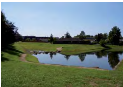
Eksempel på regnvandsbassin
