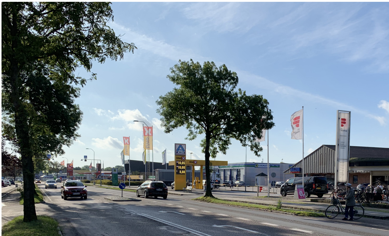
Figur 4: Planområdet set fra Vestergade. Her er karakteren af blandet erhvervsområde tydelig med både dagligvarebutik, tankstation, autoværksted og kontor synligt. Storskala skiltningen med flagstænger, pyloner, a-skilte m.v. dominerer indtrykket af området.
