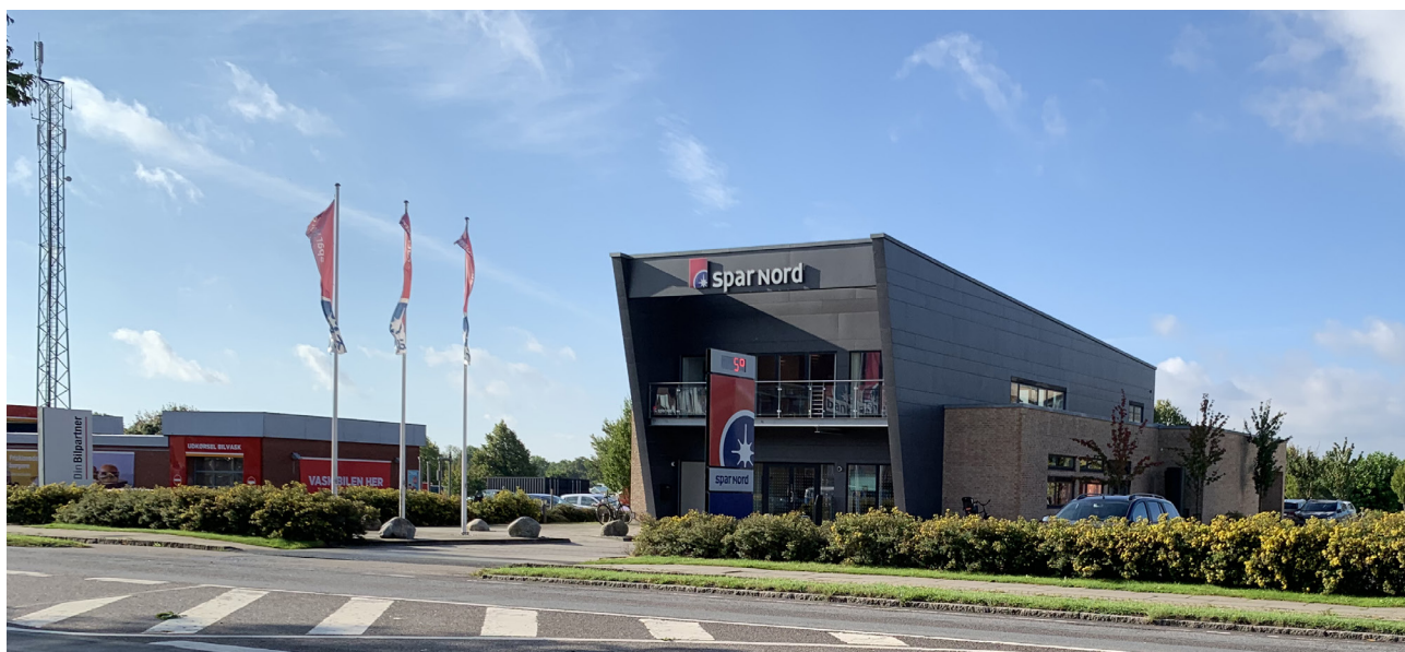
Figur 6: Spar Nords kontorbygning er tydelig i området på grund af den anderledes arkitektur og fremtoning ift. områdets andre bygninger. Til venstre i billedet ses Nyborg Texas radiomast, der fremstår tydeligt i området pga. dens højde.
