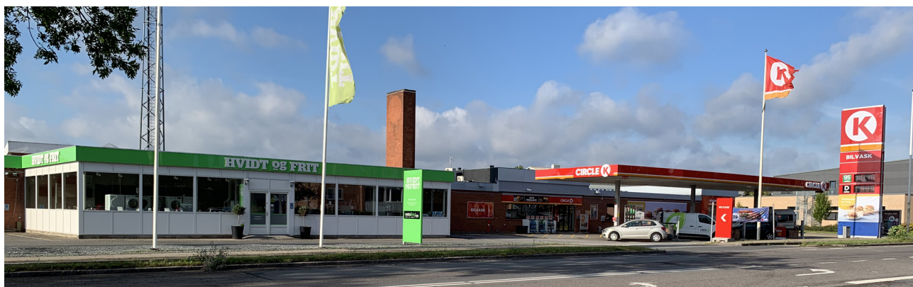
Figur 8: Hvidt og frit-butikken og Circle K tankstationen set fra Vestergade. Begge med flag og farverige pylo-ner og facadeelementer.
