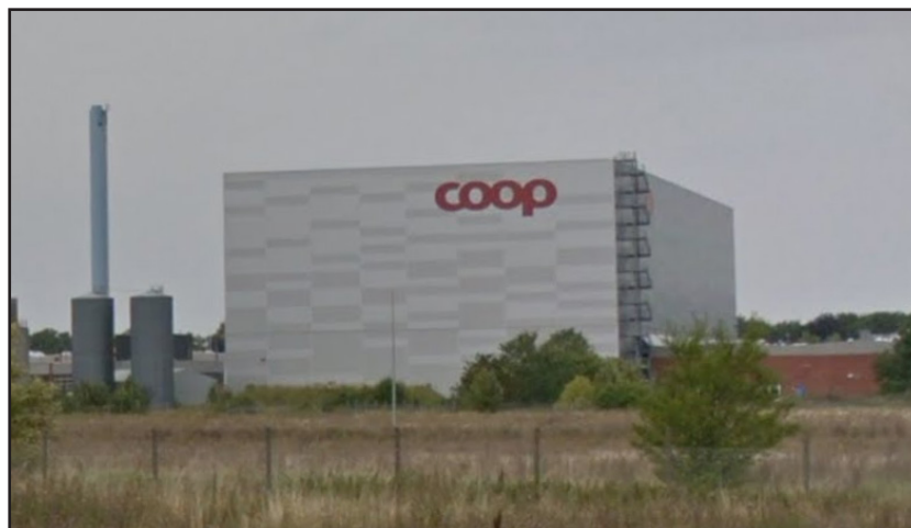
Figur 12: Referencebillede: COOPs højlager i Odense. Der er gennem varierede nuancer arbejdet med højlagerets ydre fremtræden. Med varierende placering af elementer i to grå nuancer fremstår lagret arkitektonisk interessant. Bygningen virker lettere i toppen, hvor den lysegrå nuance dominerer, og mørkere i bunden, hvor den mørkegrå nuance dominerer. Billede fra Google Earth, august 2017.
