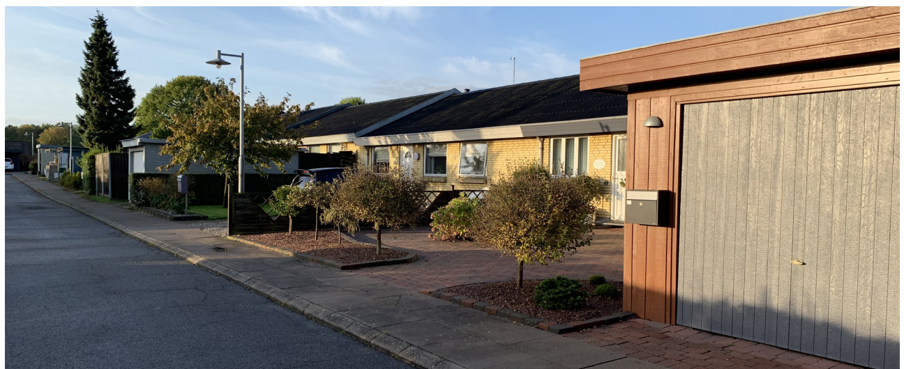
Figur 6 - Boligvænge, Harevænget, med rækkehusene i gule teglsten og vekslende carporte og garager.
