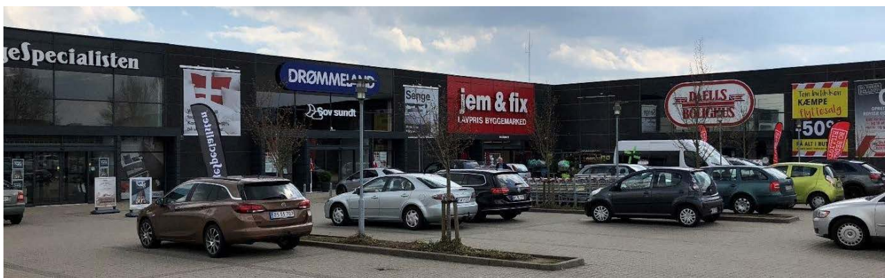
Figur 12: Referencebillede. Butiksområder med store udvalgswarebutikker er som regel kendetegnet ved store neutrale "box"-bygninger i neutral arkitektur og neutrale, ensartede facadematerialer. I stedet er det typisk butikkernes indgangspartier, logoer og skiltning, der træder frem og giver området karakter. Parkeringsarealer placeres med god adgang til butikkerne.
