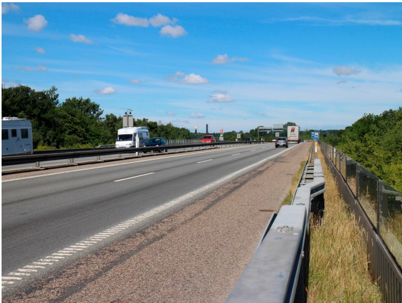
Kig til pylonerne fra motorvej E20 i vestgående retning. Den planlagte pylon står til højre for den eksisterende pylon ved OK tanken.
