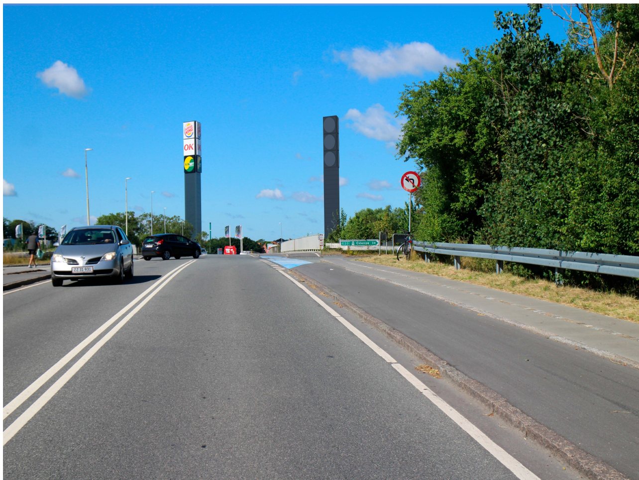
Herover ses pylonen tæt på, på vej over broen over motorvejen og jernbanen - kig mod syd afkørsel 45 Nyborg Ø.
