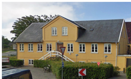
Den bevaringsværdige bygning (gl. mejeribestyrerbolig)
