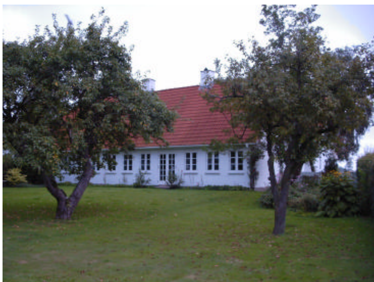
Facade mod sydøst – set fra haven
