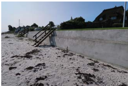
Figur 10: Kystsikring ud for Strandløkkevej 5 og 7.
