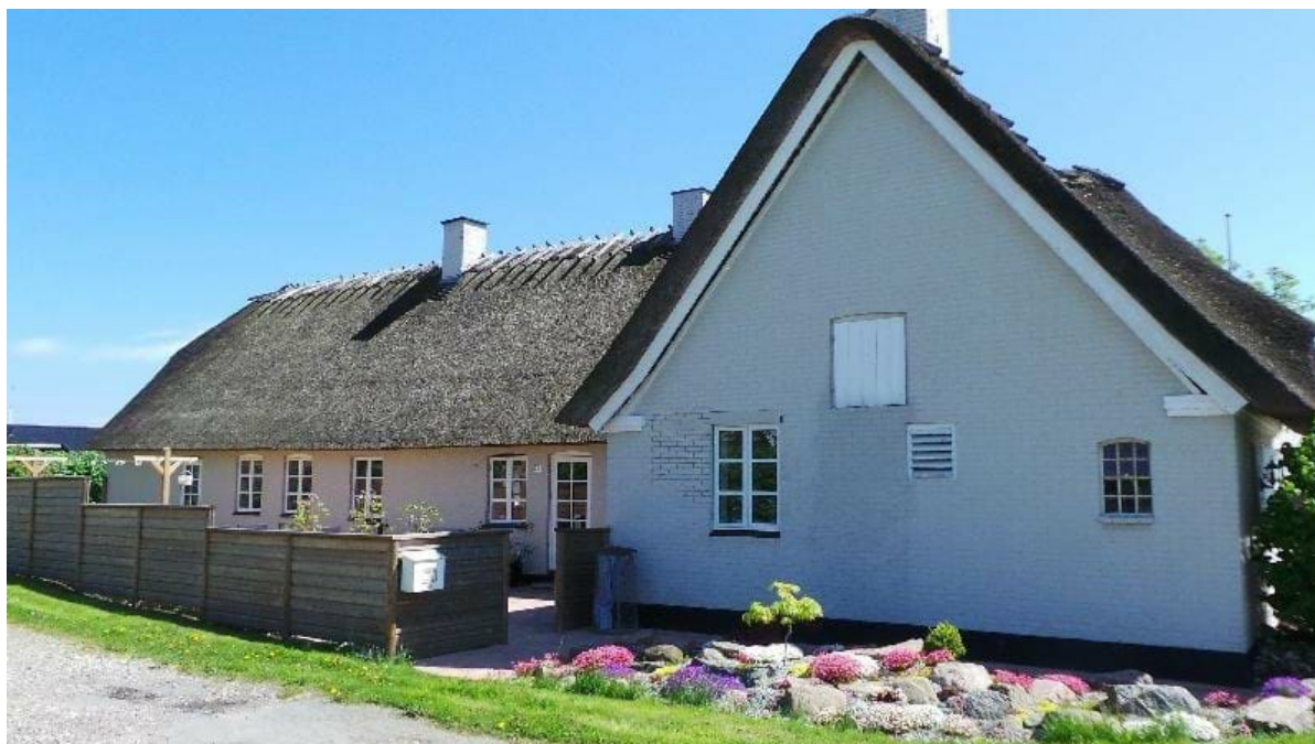
Figur ovenstående: Nordenhusevej 23, fra 1900 har en bevaringsværdi på 4
