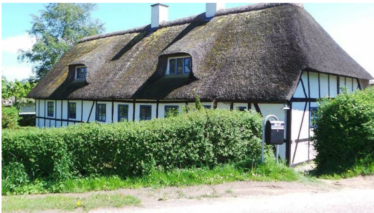
Figur ovenstående: Nordenhusevej 25, fra 1870 har en bevaringsværdi på 4
