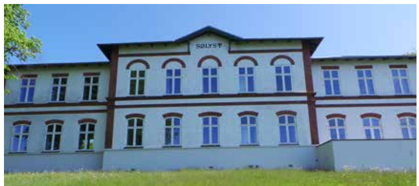
Den bevaringsværdige hovedbygning Sølyst - 2013
