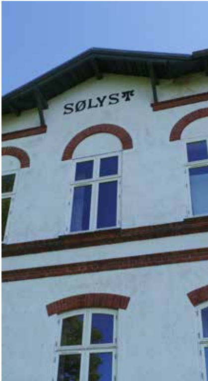
Bevaringsværdige detaljer på hovedhuset
