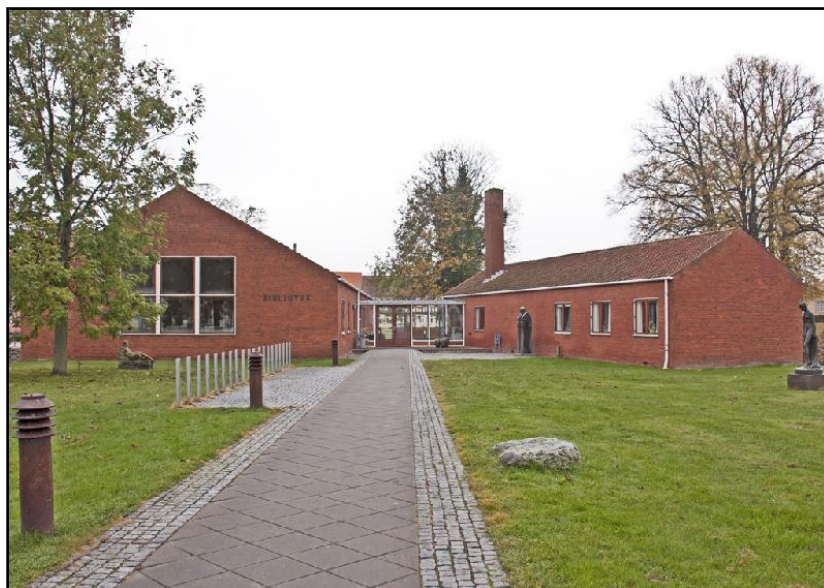
Figur 19: Den fredede biblioteksbygning, Torvet 11. Bygningen er udført i røde teglsten. Bygningen består af to lave fløje, der er placeret så bygningernes ydermur står direkte ovenpå voldgravens stensætning. Placeringen er asymmetrisk efter holmens form, der trækker de to fløje fra hinanden, og skaber udsyn mellem Torvet på den ene side af biblioteket og slottet på den anden.
