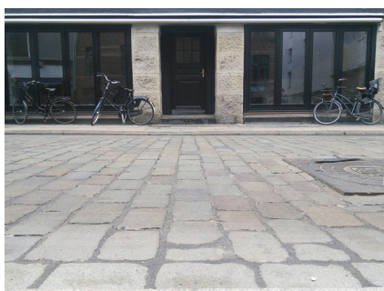
Figur 18: Brostensbelægning på Værnedamsvej, Frederiksberg Kommune.
