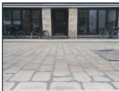
Figur 23: Brostensbelægning på Værnedamsvej, Frederiksberg Kommune.
