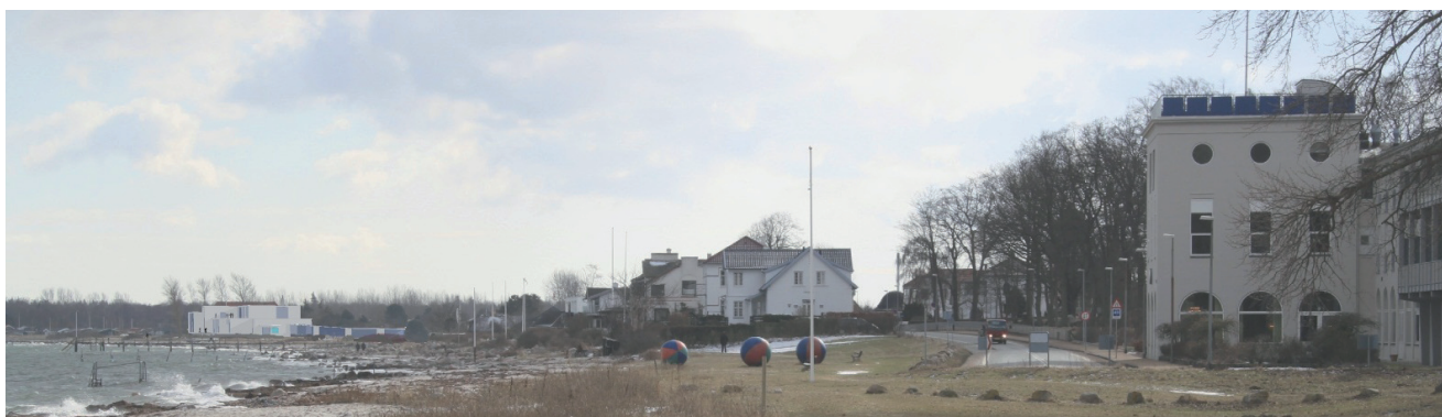
Nybyggeri set fra Hotel Nyborg Strand, bagved den nye bygning, vises taghøjden på den eksisterende hovedbygning, som nedrives.
