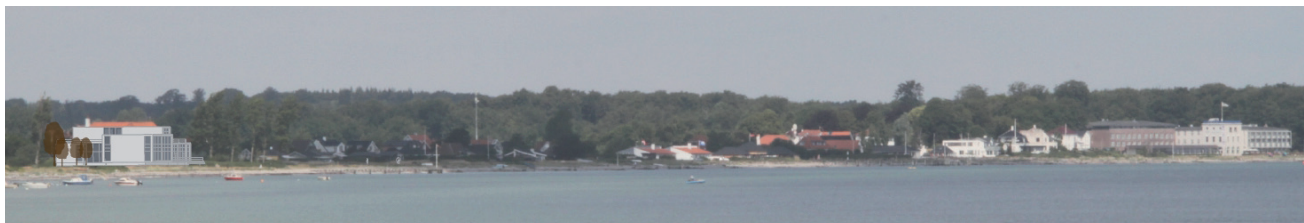
Det nye byggeri set fra lavbroen. Bag nybygningen ses taget af den eksisterende hovedbygning, som nedrives. Længere mod nord ses Hotel Nyborg strand.
