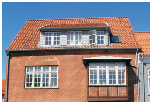
En pultkvist på bygning ved Dronningensvej.
