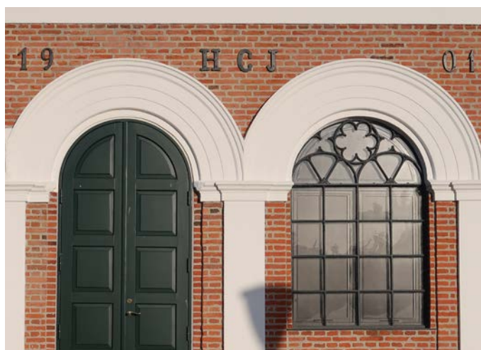
Slotsmøllens facade er opført i tegl med pudsede vindues- og dørbuer.
