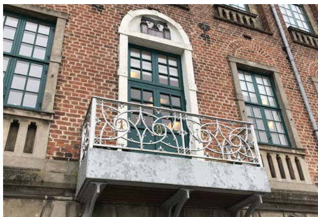
Rådhusets altan ud mod Torvet, der i sin detaljering er i overensstemmelse med bygningens arkitektur.
