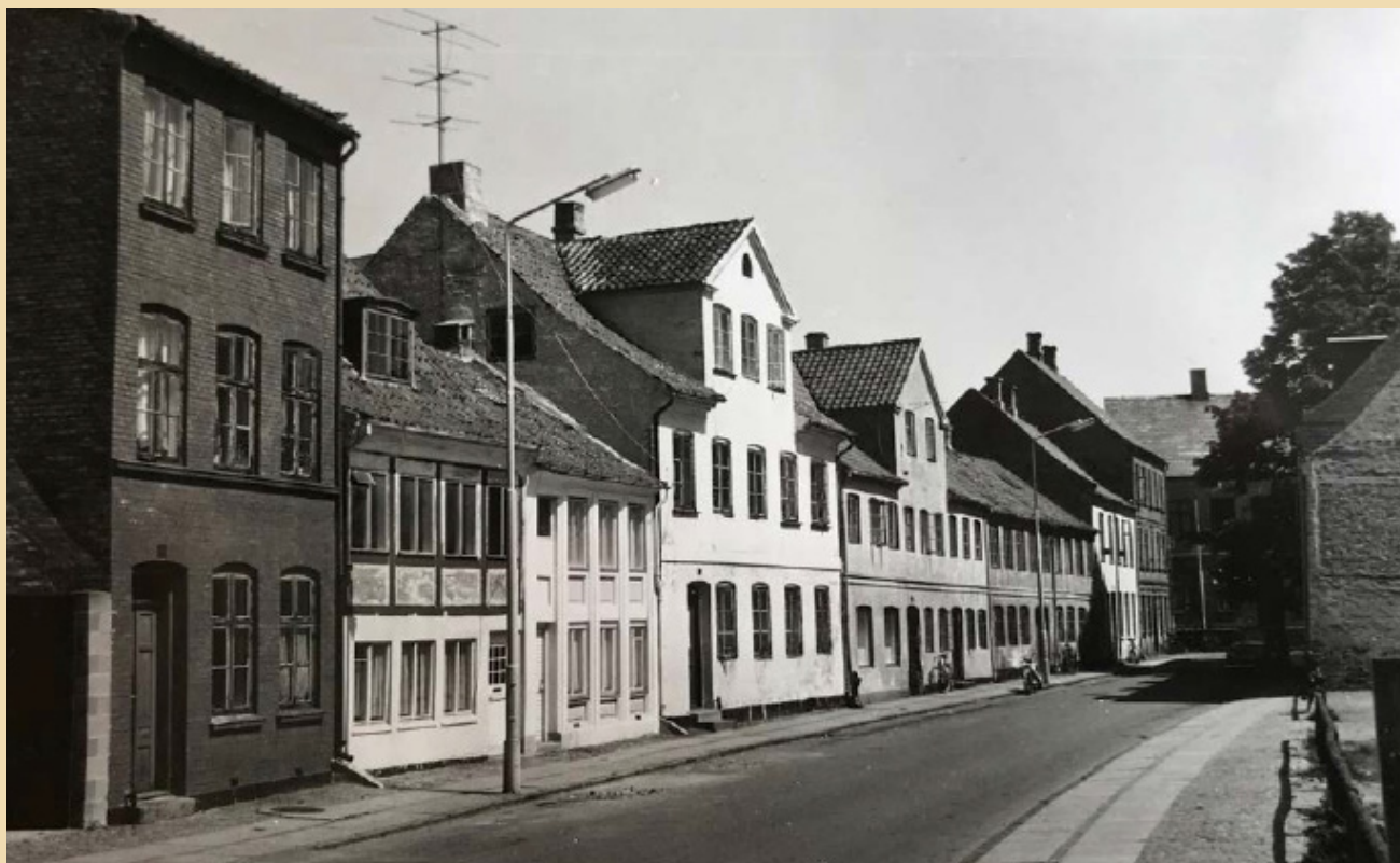
Nyenstad før sanering. Foto: Peter Dragsbo, 1968.
