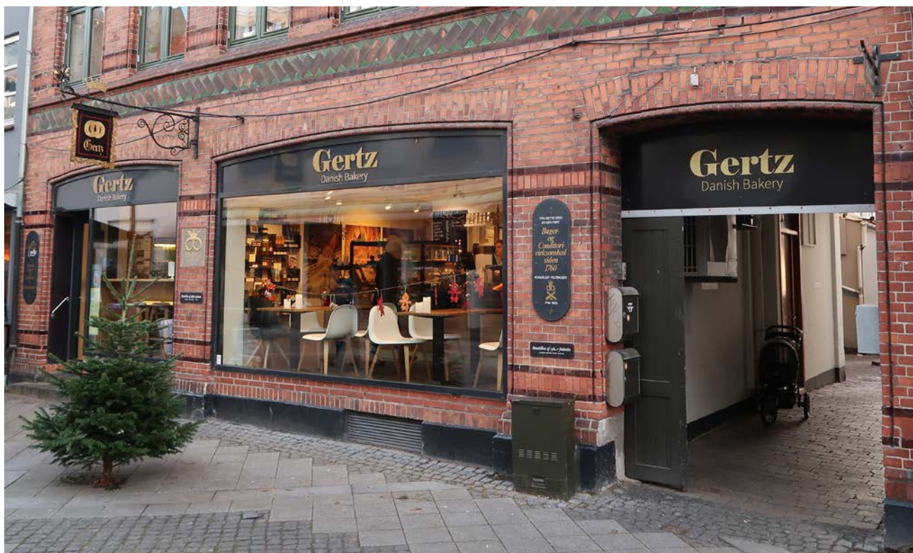
Butiksfacade i Kongegade med skiltning, der underordner sig facaden.
