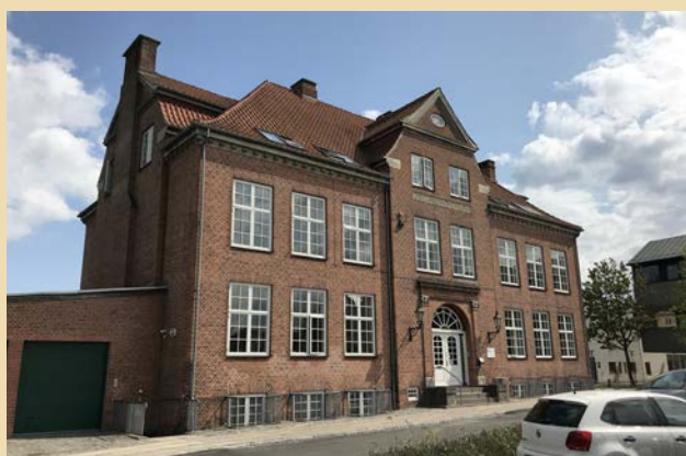
Grundskolebygningen, Nørrevoldgade 9, er opført i 1916 og har enkle, afdæmpede detaljer. Midterpartiet er fremhævet, men murværket roligt, vinduessætningen regelmæssig og vinduerne ens.
