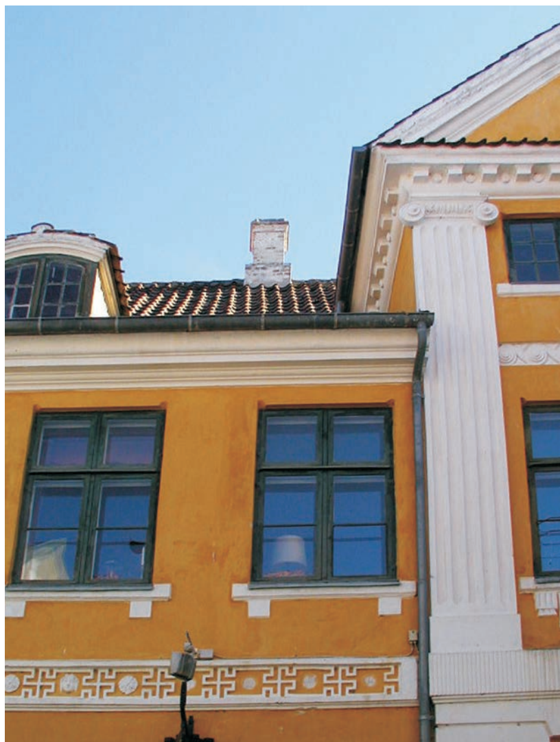
Bykernen er rig på bygningsdetaljer, som er vigtige at bevare.
