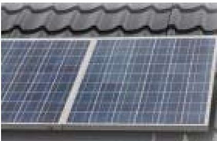
Solceller placeret plant med tagfladen og tilpasset materiale og farvemæssigt.
