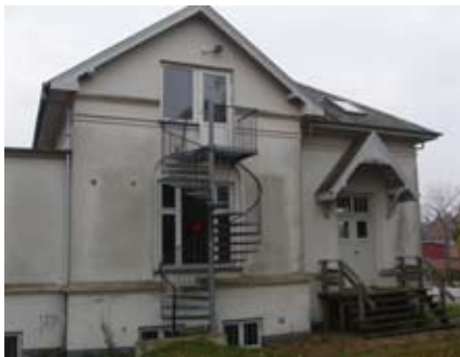
Eksisterende spindeltrappe og nyere dørparti på 1. sal som fjernes og erstattes af vindue.
