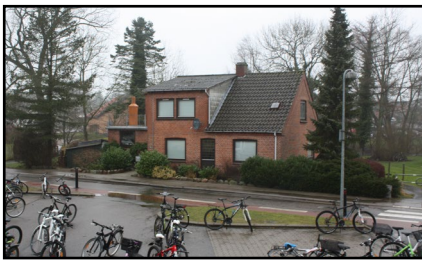
Figur 3 - Sentvedvej 3 ligger lige overfor den nordlige indgang til 4Kløverskolen. Ejendommen påtænkes nedrevet og arealet udnyttet til parkering og park.
