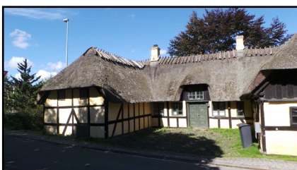
Figur 12 - Sentvedvej 1 - Almas Hus - er fredet med sit stråttækte tag og gule bindingsværksfacader.
