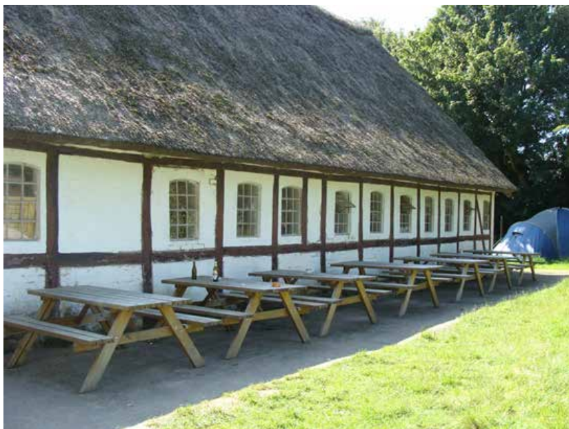
Gårdens udlænge indholder servicefaciliteter for sæsonarbejderlejr.
