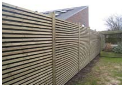
Eksempel på støjskærm Noistop Wood som nævnt i støjrapport. I lokalplanbestemmelserne fastlægges at den skal begrønnes med klatreplanter.
