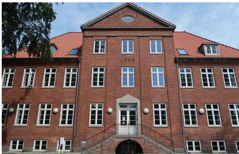
Billede 5: Provst Hjortsvej 9E. Nyborg Kommunale musikskole. Bygningen har SAVE-værdi 3 og er optaget i kommuneplanen som bevaringsværdig. Opførelsesår 1932.
