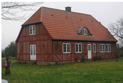
Figur 10: Brændeskovvej 48. Bygningen har en høj bevaringsværdi.
