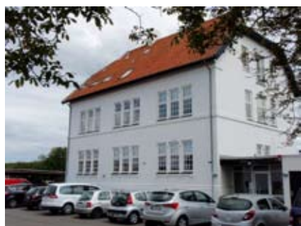
Den bevaringsværdige hovedbygning (bagfacade)
